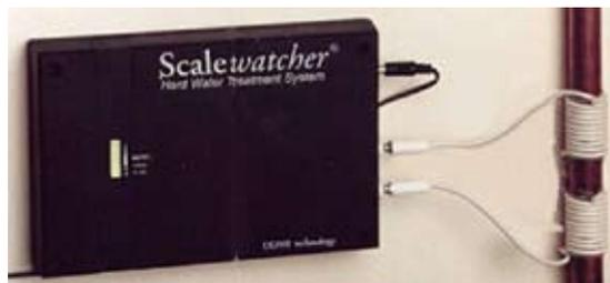
Figura 11. Dispositivo comercial antical Scalewatcher instalado en una tubería de agua.
