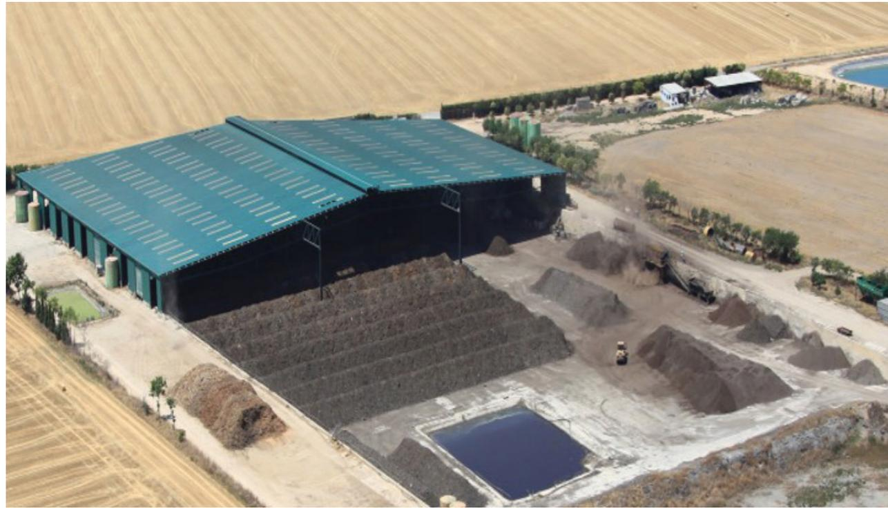
Planta de compostaje abierta que utiliza pilas volteadas
