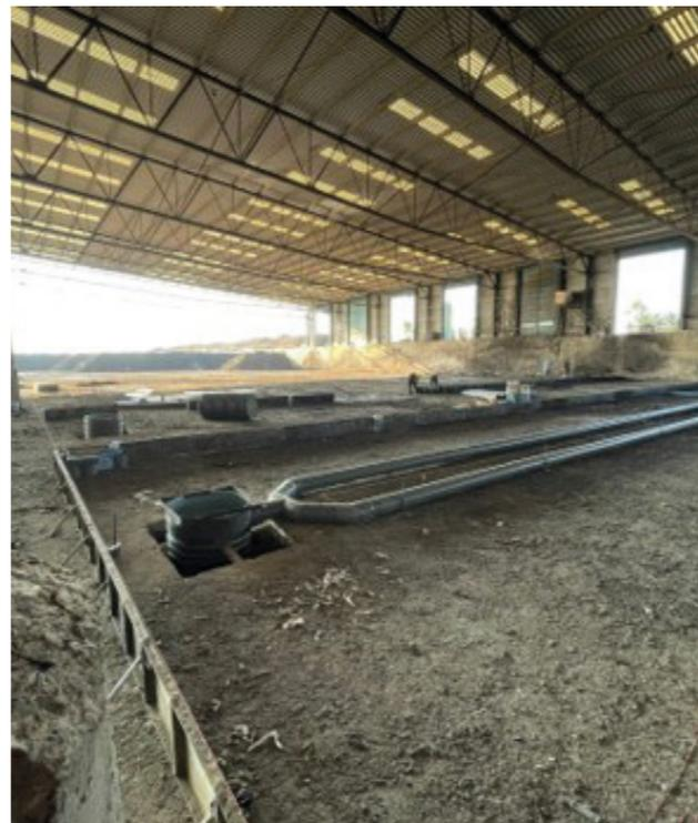
Proceso de transformación de inyectores de aire
