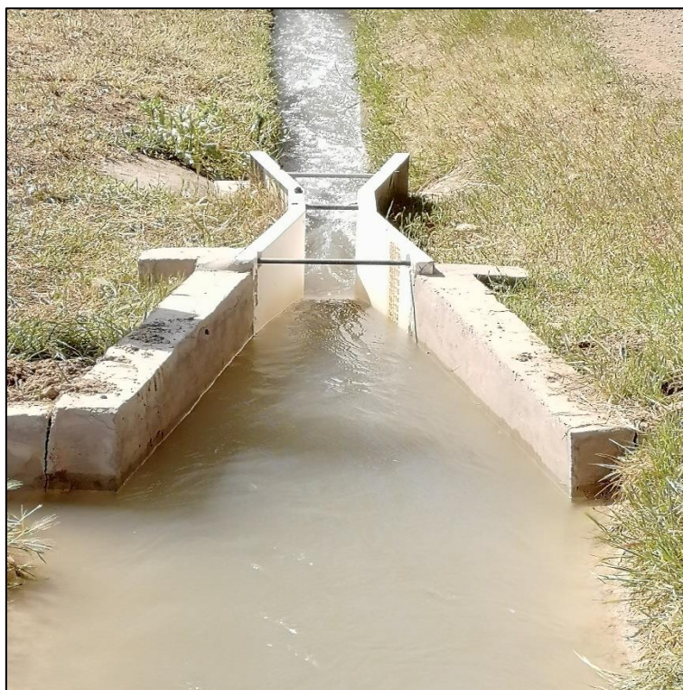
Figura 23. Aforador Parshall.
