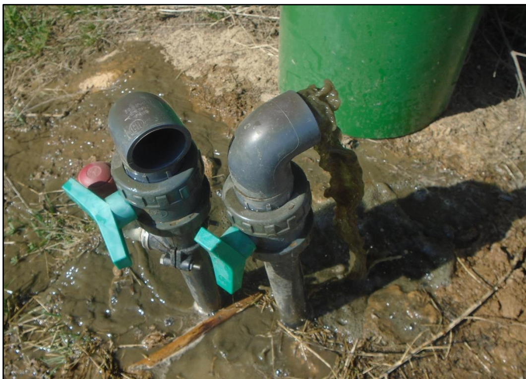
Figura 6. Limpieza de las tuberías a fecha 28/02/2019.
