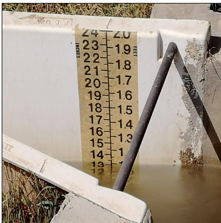
Figura 24. Regla del aforador para medir la altura de calado.
